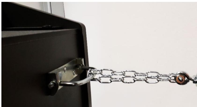
*Detalle anclaje del mueble a la pared*
